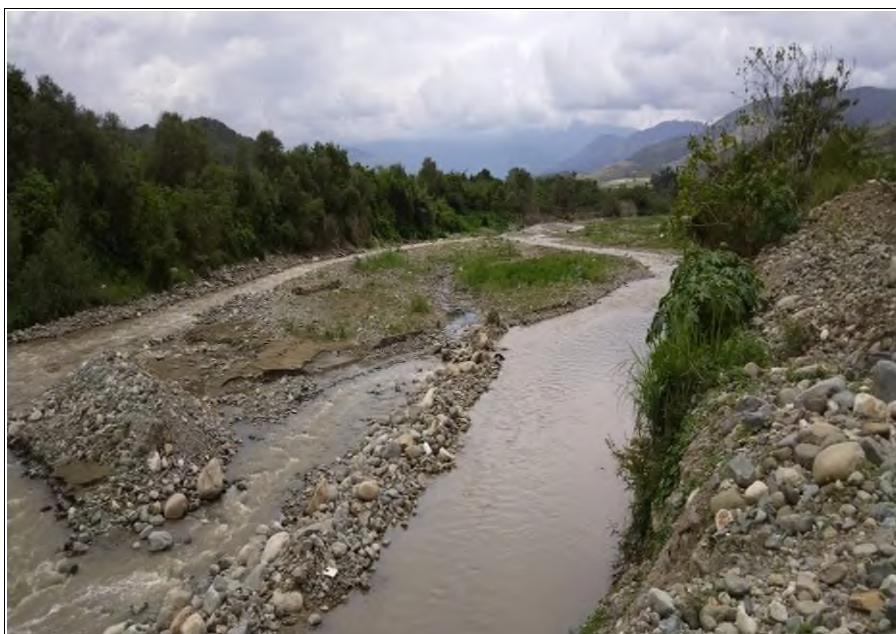
Fotografía N° 02: Colmatación de Bocatoma Canal Tororrume.
